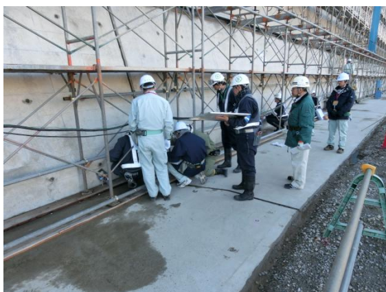
たて壁の下部補強部 点検の様子
