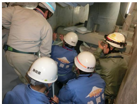
配管サポート取付状態 点検の様子
