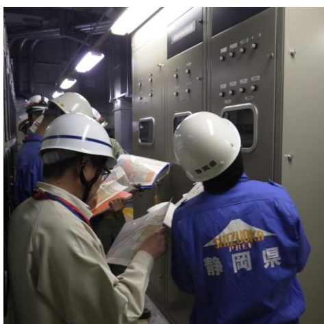
電源盤の上層階への設置工事点検の様子
