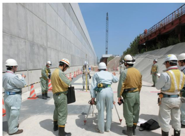
防波壁設置工事点検の様子
