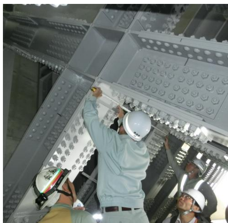
防波壁設置工事点検の様子
