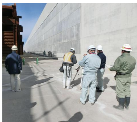
防波壁設置工事点検の様子
