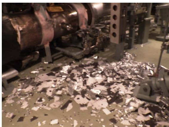
原子炉格納容器の様子
