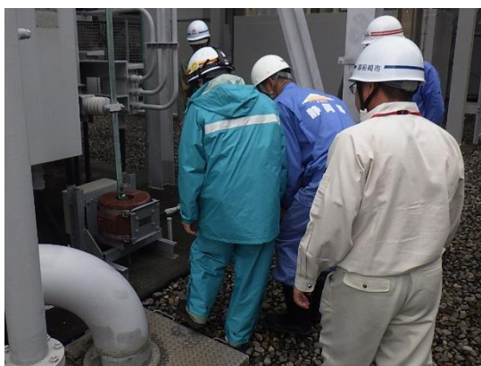
変圧器一相開放対策 点検の様子
