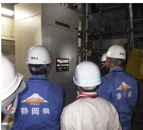
制御盤耐震性向上工事(原子炉隔離冷却系・補給水系) 点検の様子
