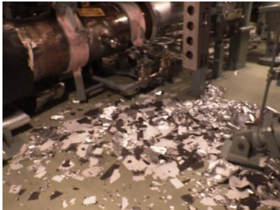
原子炉格納容器の様子
