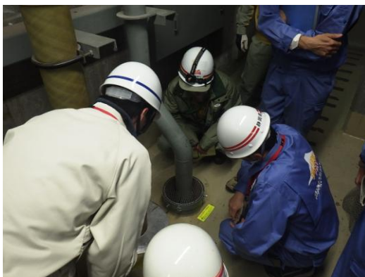
溢水経路の形成工事 点検の様子
