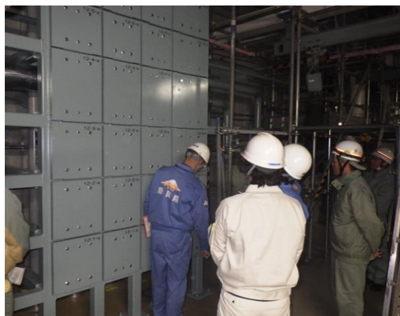
原子炉建屋における換気空調系開口部の竜巻対策 点検の様子
