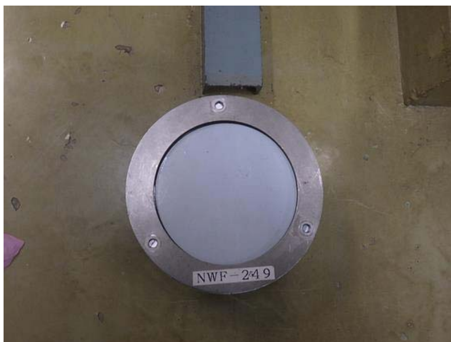
NRW- I 地下 1 階 南西側エリア
