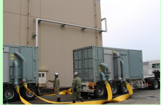
代替熱交換器車両設置の様子
