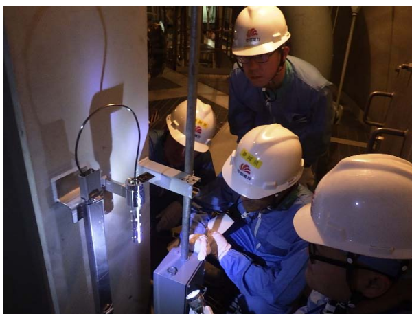
格納容器水位監視強化対策工事 点検の様子
