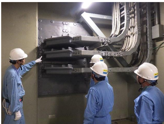
共用施設の溢水対策工事 点検の様子
