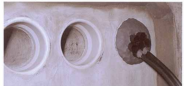
第3図 分割管路端末部(マンホール)
