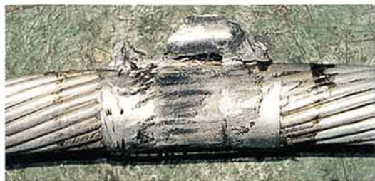
第4図 接続部の外観
