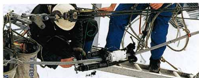
第3図 接続作業状況
