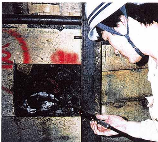
第2図 受振センサー設置状況
