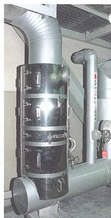
第3図 ケース充填保温材装着図
