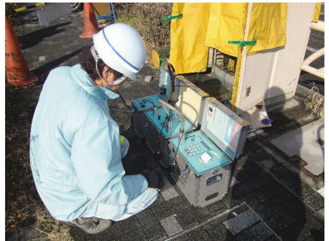
写真1 現場作業状況
