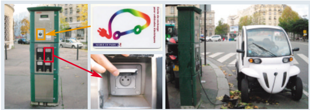
第3図 パリの路上駐車場に設置されている充電装置および利用状況
