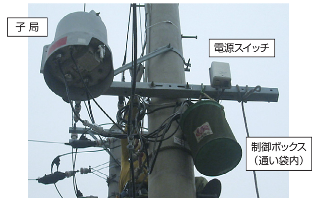
第4図 作業性検証風景
