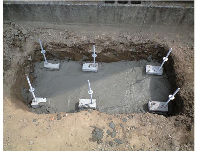
第5図 転倒防止機構の設置状況(その2)
