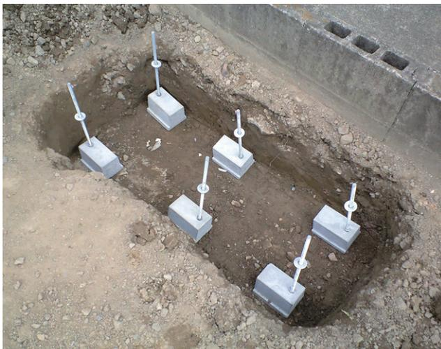
第4図 転倒防止機構の設置状況(その1)
