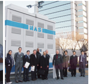
500kW NaS電池システム 見学の様子
