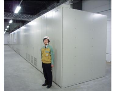
10MVA電気二重層キャパシタ式瞬低補償装置
