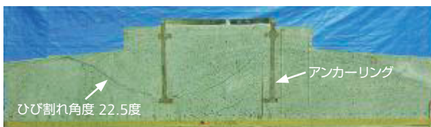
第4図 試験体切断面のひび割れ状況(試験体No.1)
