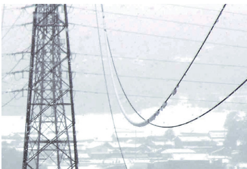
第1図 架空送電線への着雪例
