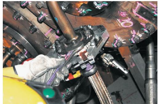
第4図 フランジ締付治具の使用状況
