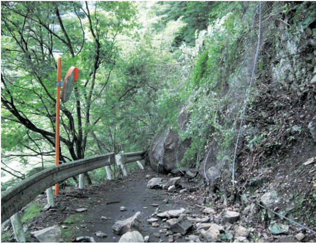
第3図 被災地状況
