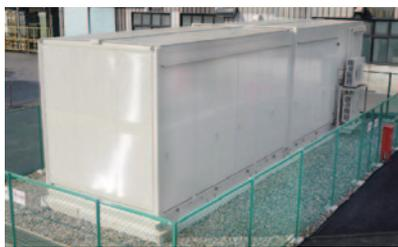
リチウムイオンキャパシタ式短時間停電補償装置
