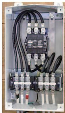
電磁接触器動作音低減タイプ
