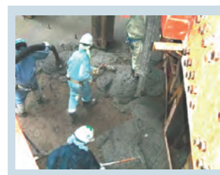
第5図 打設・充填状況
