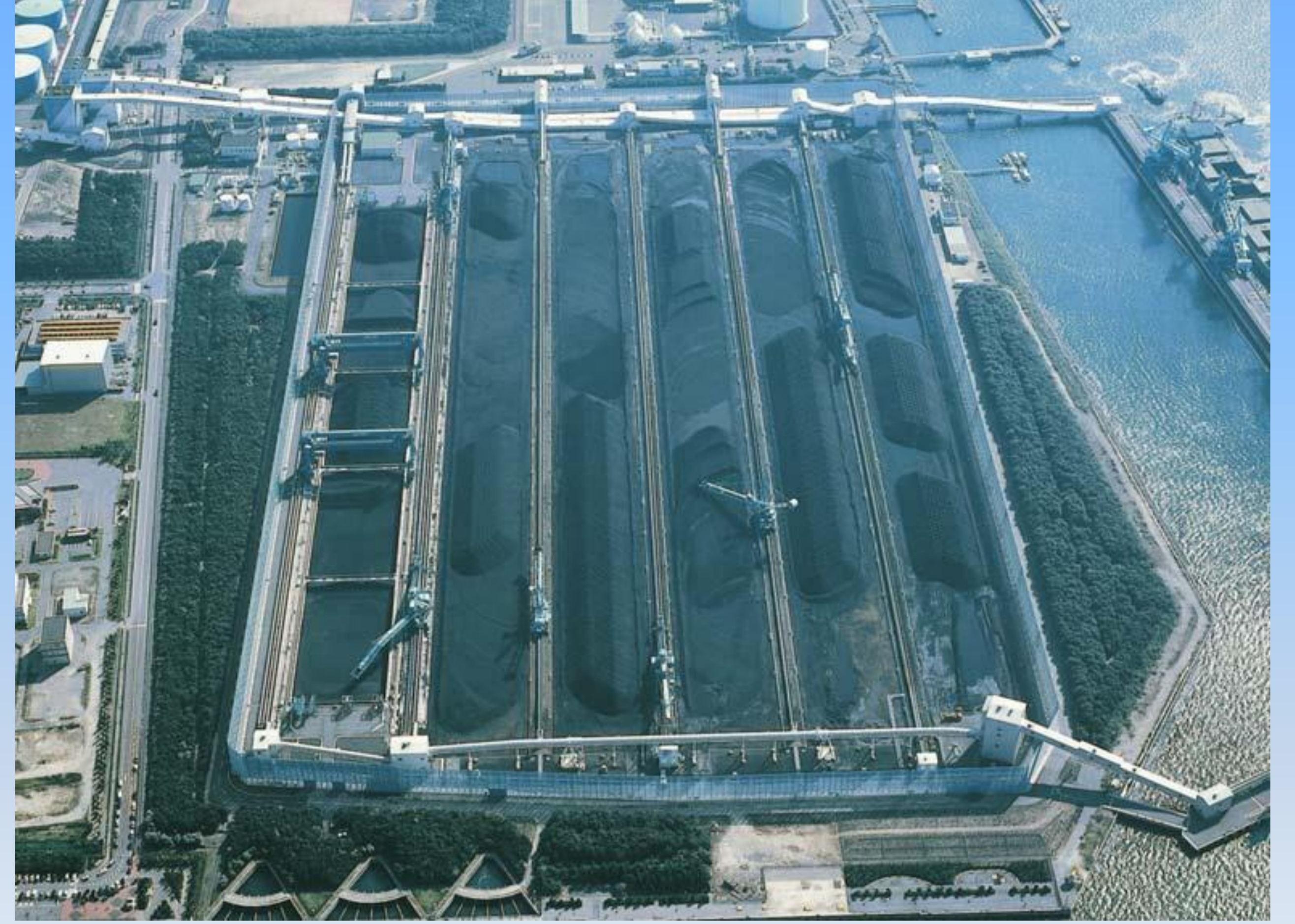
碧南火力発電所 貯炭場
