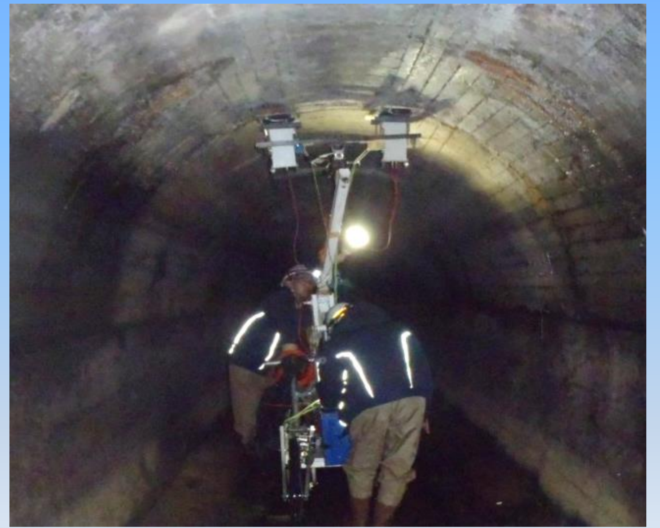
トンネル内でのレーダ探査状況
