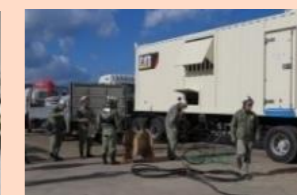
電源車操作訓練
