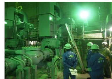
緊急時海水取水設備（EWS）の設置工事点検の様子
