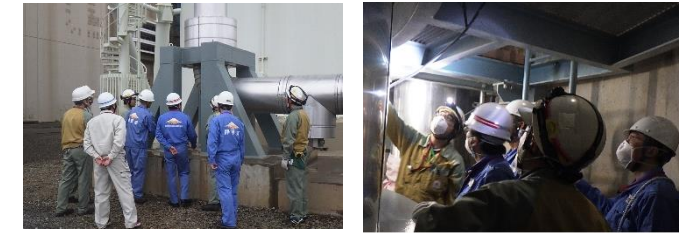
フィルタベント設備設置工事点検の様子
