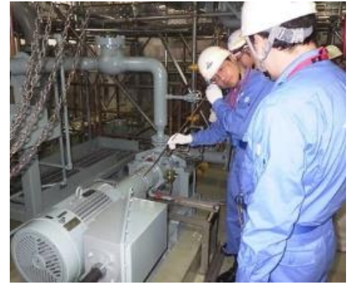
空冷式熱交換器（緊急時機器冷却水ポンプ）点検の様子
