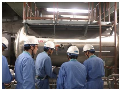
格納容器pH制御設備（タンク）点検の様子
