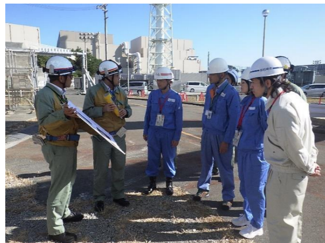
フィルタベント放射線監視強化対策工事点検の様子【第88回（10月9日）】
