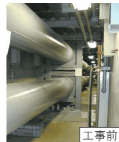
配管サポート耐震補強
