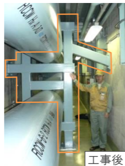
配管サポート耐震補強
