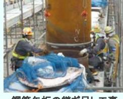
钢管矢板の継ぎ足し工事
