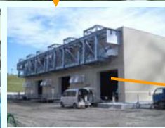
ガスタービン建屋
