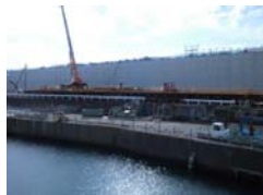
嵩上げ工事の 作業用構台を 設置しています。
