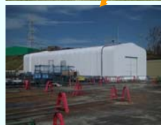
緊急時資機材倉庫建屋工事
