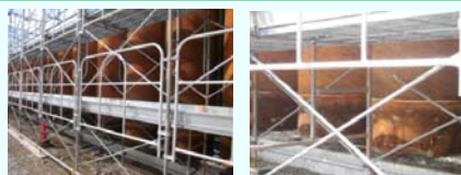
継ぎ足しされた鋼管矢板
