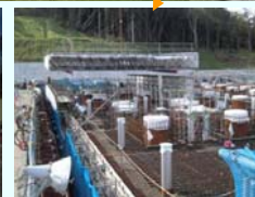
燃料タンク設置現場
