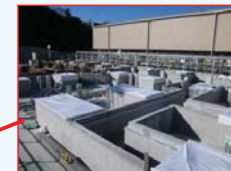
燃料タンク設置現場
