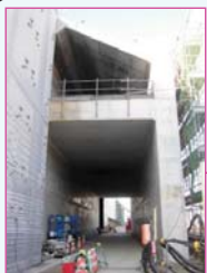
箱桁(東側から撮影)
