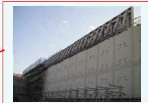
東側改良盛土付近
