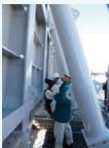
防波壁嵩上げ部の点検の様子
