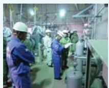
4号機緊急時海水取水設備の点検の様子
