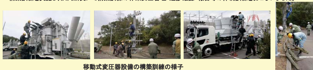
移動式変圧器設備の構築訓練の様子
