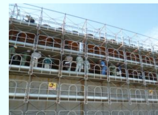
西側端部嵩上げ部点検の様子
