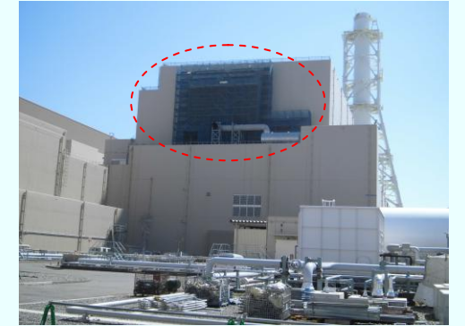
4号機原子炉建屋に設置された工事用足場
