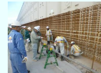
一般部たて壁下部補強部点検の様子
