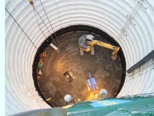
3号機フィルタベント室掘削工事の様子
