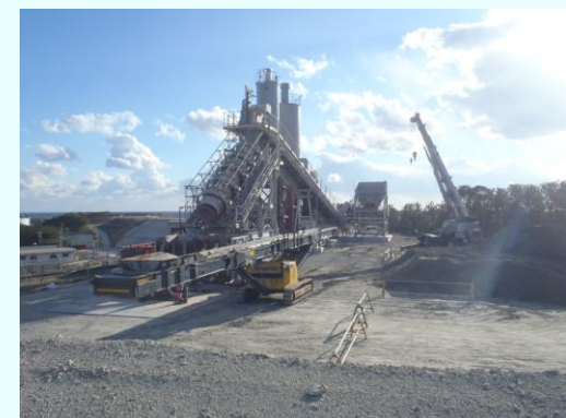
西側盛土現場に設置された改良土プラント
