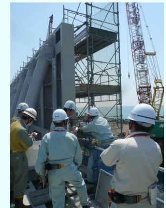
一般部壁部(継壁)点検の様子
