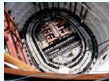
4号機 フィルタベント室 本体工事の様子
