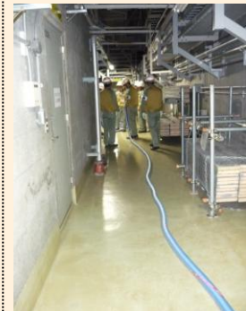
原子炉建屋内におけるホースの敷設ルート確認および接続訓練
