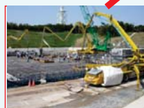
地下水槽 コンクリート 打設工事 (4/23)
