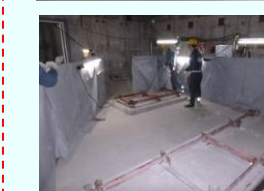
●ポンプ室内作業の様子
