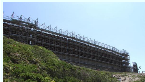
●防波壁西側端部工事現場を海側 から見た様子
