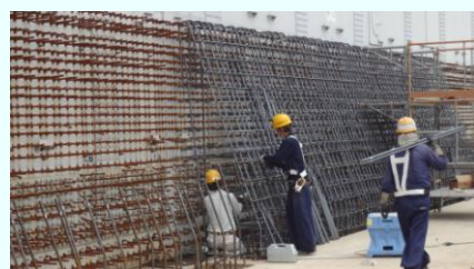
●防波壁下部補強工事作業の様子
