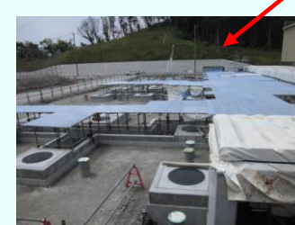
●燃料タンク現場
