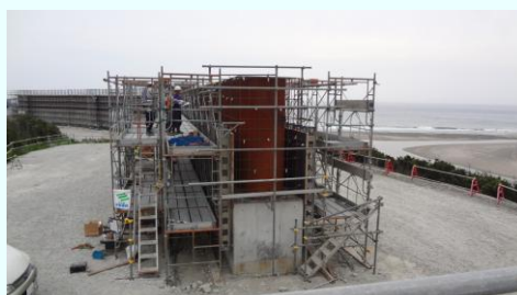
●防波壁西側端部嵩上げ工事の様子
