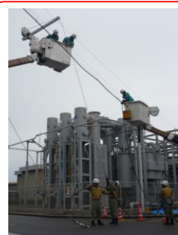
建設した電柱から5号機の電源設備まで配線の延線訓練を実施
