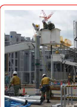
バケット車を使用して複合柱(パンザマスト)の建設
