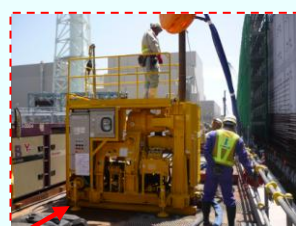
●地盤改良工事に用いる 高圧噴射攪拌機
