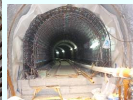
配管トンネル工事 の様子
