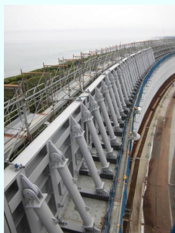
●防波壁嵩上げ部据付後の様子 <嵩上げ部据付の進捗> 132箇所/218箇所 (6/1現在)
