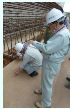
一般部たて壁下部補強部点検の様子
