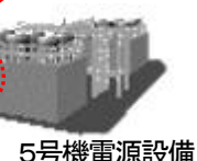
5号機電源設備
