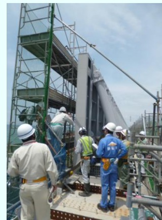
一般部壁部(継壁)点検の様子
