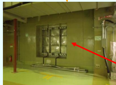
建屋ベント吸気パネル (建屋内部側)
