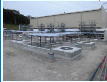
●燃料タンク現場
