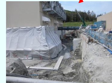
●ガスタービン発電機建屋 周辺掘削工事現場
