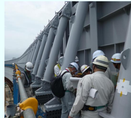
一般部壁部(継壁)点検
