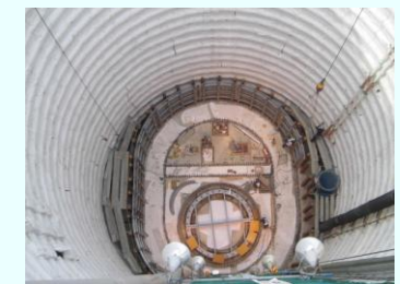
3号機 フィルタベント室 本体工事の様子
