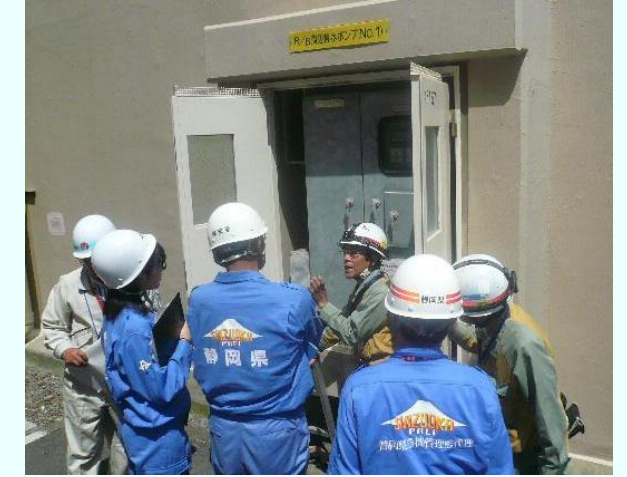
建屋外壁貫通部の止水対策点検
