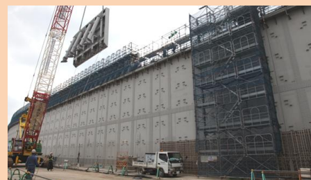
防波壁(海拔22m) (海拔18mまで設置完了)
