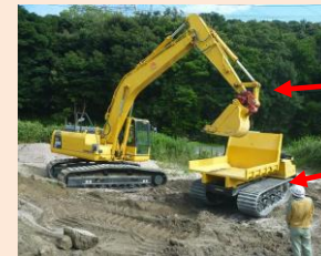
油圧ショベルによるクローラキャリア荷台への土砂積込の様子
