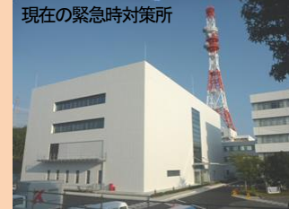
緊急時対策所の増築
