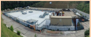
水源の多様化策 敷地高台30mの緊急時淡水貯槽
