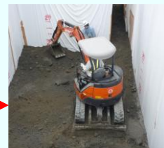
水槽側面と地面の埋戻し工事の様子
