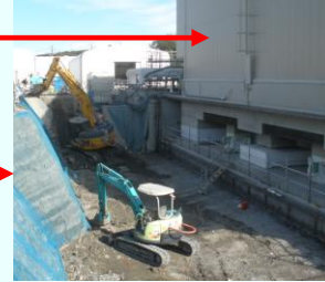
ガスタービン発電機建屋の耐震性強化工事の様子
