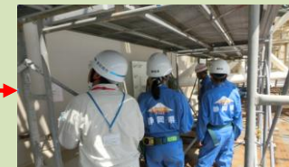
空冷式熱交換器の据付状況点検の様子
