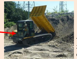
クローラキャリアからの土砂降ろしの様子
