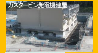
ガスタービン発電機建屋 ガスタービン発電機
