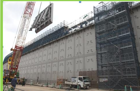
防波壁(海拔22m) (海拔18mまで設置完了)
