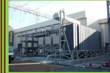
・受電用変圧器を高台25mに設置
