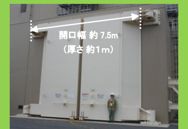
3号機大物搬入口の強化扉
