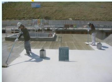
水槽頂版部の防水塗装作業の様子
