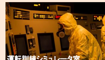
②照明が消えた中、放射性物質 の放出に備え防護装備を着用して 訓練を実施する運転員の様子
