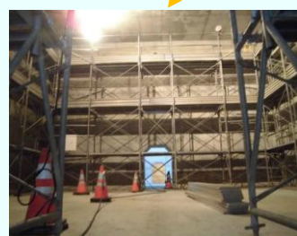
水槽内部の防水作業のための準備作業(足場組立)の様子
