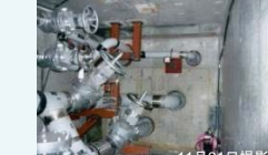
11月21日撮影 ポンプ室内部の配管設置の様子
