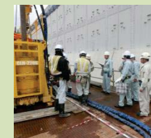
11月28日撮影 地盤改良工事点検の様子
