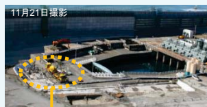
11月21日撮影 3号機取水槽工事の様子
