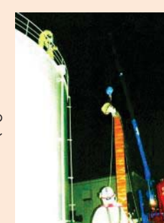
取水ポンプを吊り上げ、タンク上部に移動させている様子
