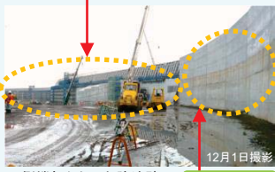
12月1日撮影 西側端部からみた防波壁
