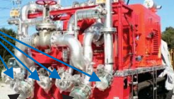
11月18日撮影 取水ポンプからのホース接続部
