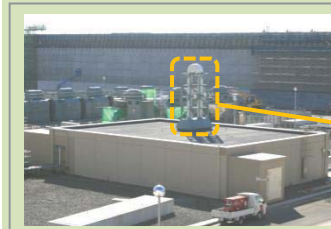
3号海水フィルタ室 ※原子炉を冷やすための水(淡水)を、海水で冷やすための系統(海水系)の電動弁や、海水からゴミを取り除くフィルタ設備などが設置されている。
