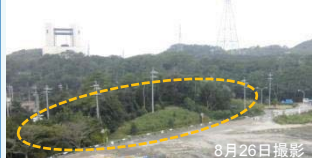
工事前の様子
