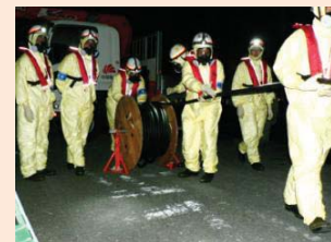
電源ケーブルを敷設している様子
