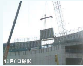
3号機放水路横断部の工事の様子 ※12月8日で海拔22mまでの嵩上げ部(4m)据付完了
