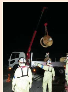
電源ケーブルをユニック車から降ろしている様子
